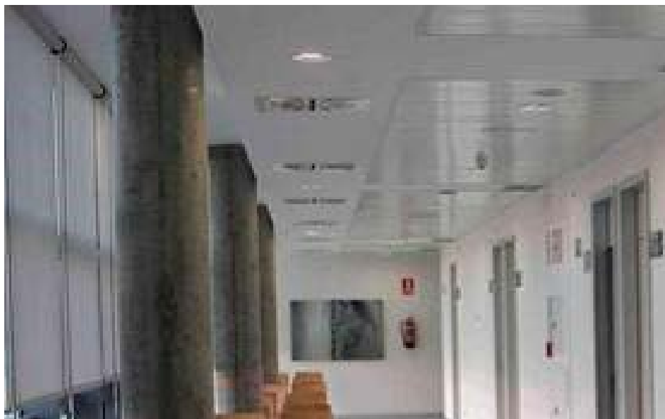
Iluminación de pasillos y salas de espera
