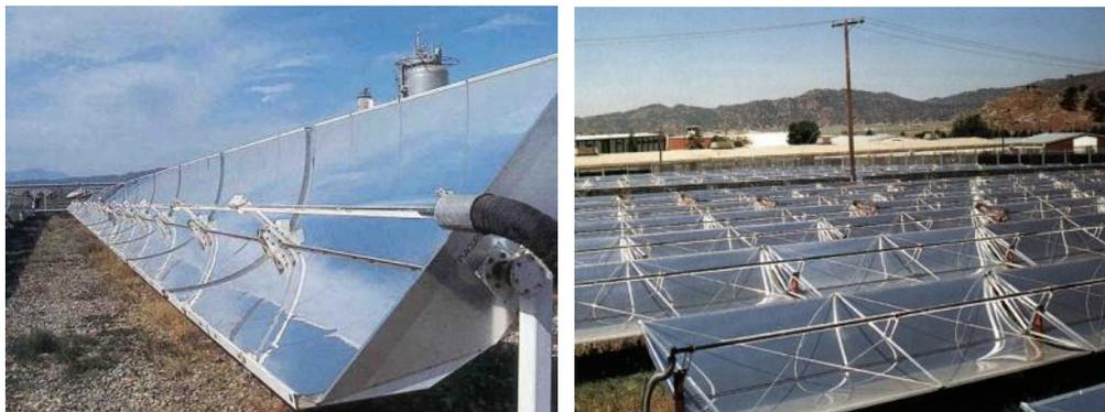
*Ilustración 28. Colectores cilindro-parabólicos con un eje de orientación este-oeste (izquierda). Aplicación de colectores cilindro-parabólicos en un proceso industrial (derecha)*
