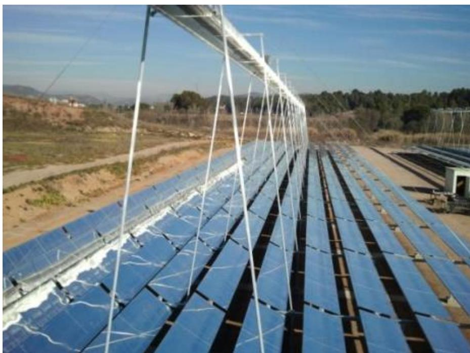
*Ilustración 30. Instalación de 3.000m<sup>2</sup> de LFC en MAFRICA*
