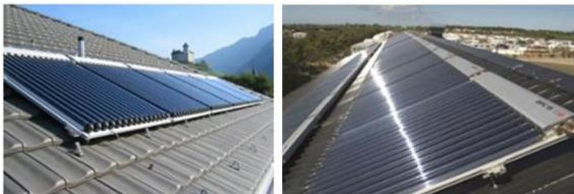
Ilustración 26. Instalación de tubos de vacío Fuente: SPF
