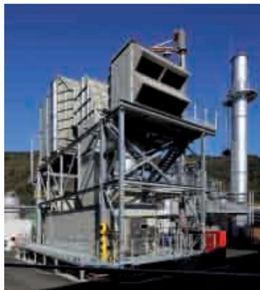
Se trata de un proyecto de cogeneración de alta eficiencia de ciclo combinado mediante turbina de gas natural y turbina de vapor con una potencia eléctrica total de 25 MW.
