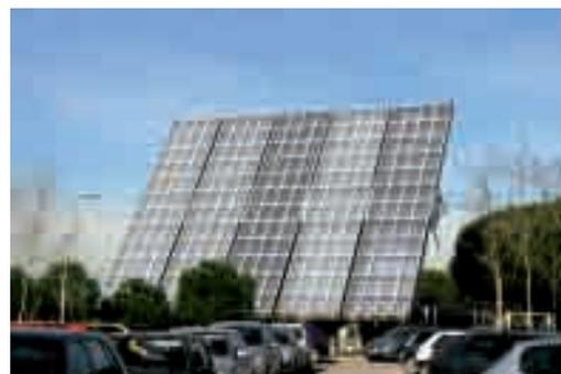
Esta instalación, en funcionamiento desde el año 2007, se considera pionera en cuanto al uso comercial de varias tecnologías innovadoras: lentes de Fresnel, células de alto rendimiento —que utilizan 250 veces menos silicio que una célula convencional y alcanzan un 18% de eficiencia— y la refrigeración mediante un sistema Venturi.
