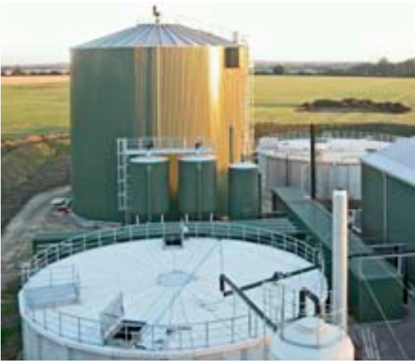
Figura 24. Fotografía de la planta de biogás Söderasens Bioenergi AB
