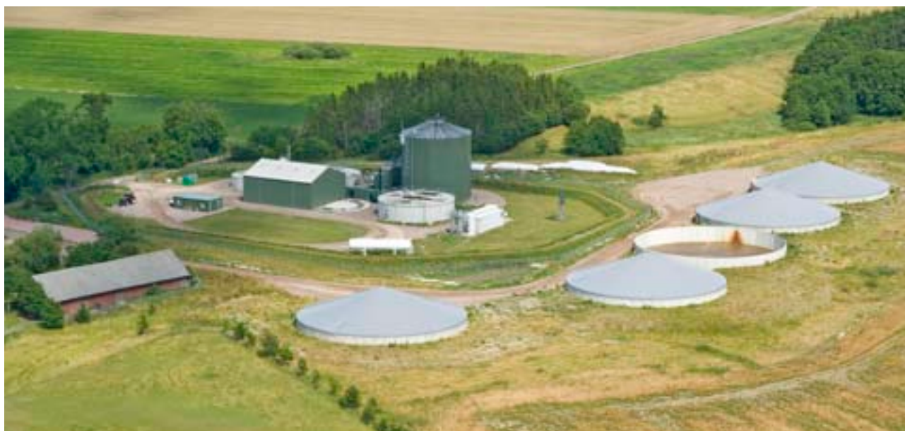
Figura 23. Fotografía aérea de la planta de biogás Söderasens Bioenergi AB
