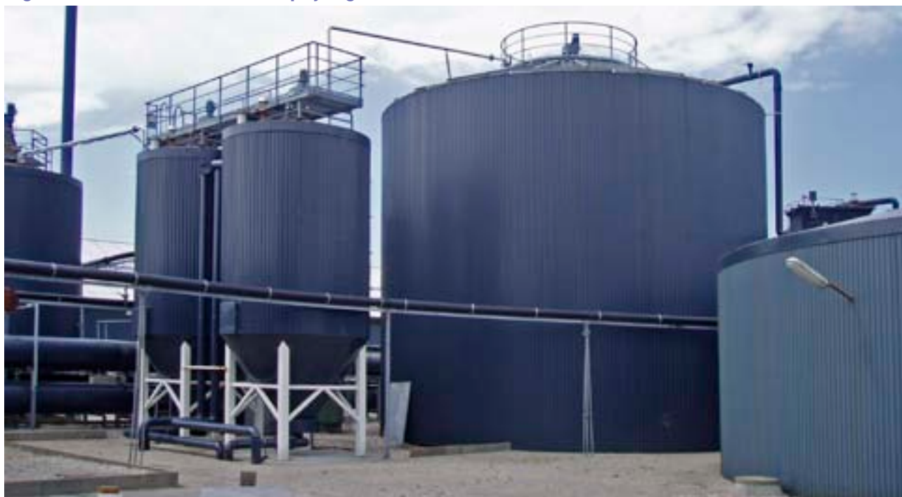
Figura 19. Pasteurizadores (izq.) y digestores (dcha.)
