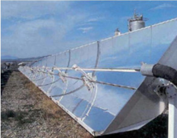
Figura 31. Colectores cilindro-parabólicos con un eje de orientación este-oeste (izquierda). Aplicación de colectores cilindro-parabólicos en un proceso industrial (derecha)
