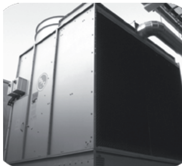
Figura 14. Ejemplo de instalación de una torre húmeda de refrigeración
