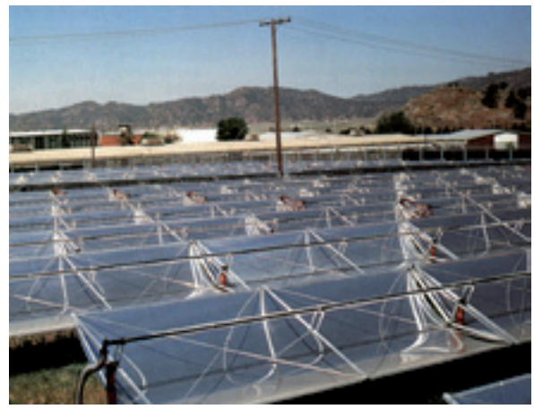
Figura 31. Colectores cilindro-parabólicos con un eje de orientación este-oeste (izquierda). Aplicación de colectores cilindro-parabólicos en un proceso industrial (derecha)
