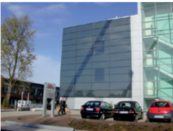
Figura 22. Instalación con colectores solares de aire realizada en Francia
