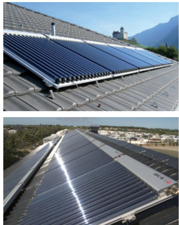
Figura 29. Instalación de tubos de vacío
