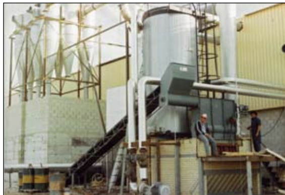
Figura 4.9: Caldera cilíndrica de aceite térmico con biomasa en la planta de Courma, Dos Hermanas.
