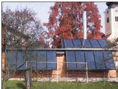
Cabina de 100 kW con almacenamiento de biomasa.
