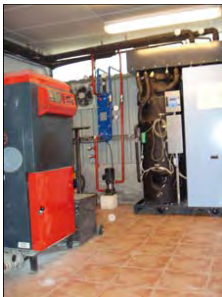
Caldera y equipo Climatewell 10 de calefacción y climatización.
