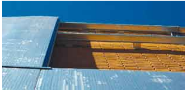
Fachada rehabilitada con paneles por el exterior
