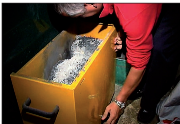
Instante de la extracción del cenicero de una caldera automática de biomasa.
