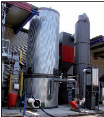
Caldera de biomasa (izquierda) y secadero de planta de pelets (arriba) de Ebepelets, Muxika (Vizcaya).
