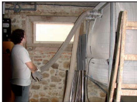
Sistema de alimentación de pelets a silo textil desde camión cisterna por sistema neumático. Centro de Agroturismo. Vizcaya.
