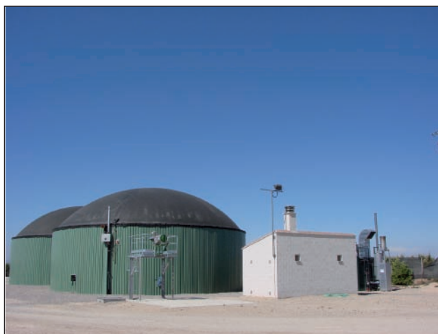
Planta de co-digestión.
