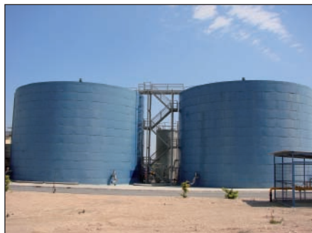
Digestores de la planta de tratamiento de purines de TRACJUSA.
