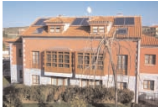
Ejemplos de integración de sistemas de captación solar a la cubierta inclinada de los edificios
