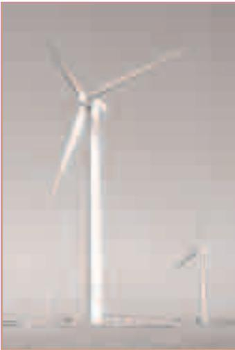
generador síncrono multipolar, con un diámetro de rotor de 70 metros y una altura de buje de 60 metros. Asimismo, IDAE aportó el 90% de la financiación necesaria para la construcción del parque de Olite, mediante una compra-venta aplazada de los equipos.
