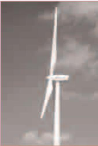
Todas las turbinas son tripala, de paso y velocidad variables, con un generador asíncrono que genera a media tensión para reducir pérdidas. De todas ellas, 30 máquinas están diseñadas como clase III (con 77 metros de diámetro de rotor), una clase II (70) y otra clase I (70). La altura de la torre es de 77 metros y el modelo comercial de la pala utilizado es LM 37.3 P.
