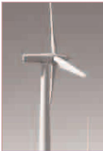
ángulo de paso de la pala, permitiendo la entrada en pérdida sucesiva e independiente de los perfiles, una vez alcanzada la potencia nominal del generador.
