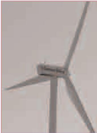
funcionamiento, pero es propiedad de Gamesa Eólica y no de Sistemas Energéticos). Entre estos aerogeneradores destaca justamente el G80 de 2.000 kW por ser esta la potencia nominal más alta de las turbinas instaladas por Gamesa. El diámetro del rotor de estas máquinas de paso y velocidad variables es de 80 metros y su área barrida de 5.027 metros cuadrados. La torre mide 67 metros de alto y el juego de palas empleado es suministrado por Fiberblade.
