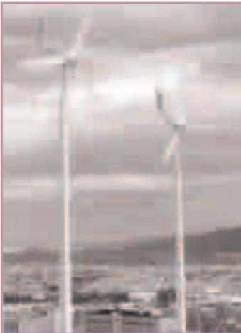
Todas las máquinas son del modelo Vento 5000. Unas turbinas tripala, de paso fijo y generador síncrono de imanes permanentes, con una potencia nominal de 5 kW. El diámetro del rotor es de 5 metros y la torre que lo sostiene de 15 metros. Las palas están también diseñadas y fabricadas en Yecla por Windeco Tecnología Eólica.
