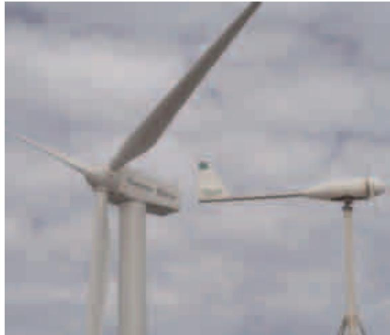
En el caso de las palas de paso fijo, cuyo anclaje al buje no permite moverlas, el diseño de la pala hace que, llegados a una velocidad de viento alta, sean los propios perfiles los que entren en pérdida, controlando aerodinámicamente la potencia de salida.
