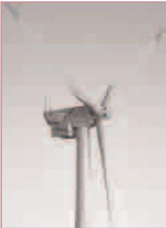
El aerogenerador dispone de un diámetro de rotor de 104 metros y la superficie barrida es de 8.495 metros cuadrados. La altura de la torre mide 100 metros y se compone de una parte de hormigón de 70 metros y otra de acero de 30 metros. La pala que monta ha sido fabricada por LM y su longitud es de 50 metros.
