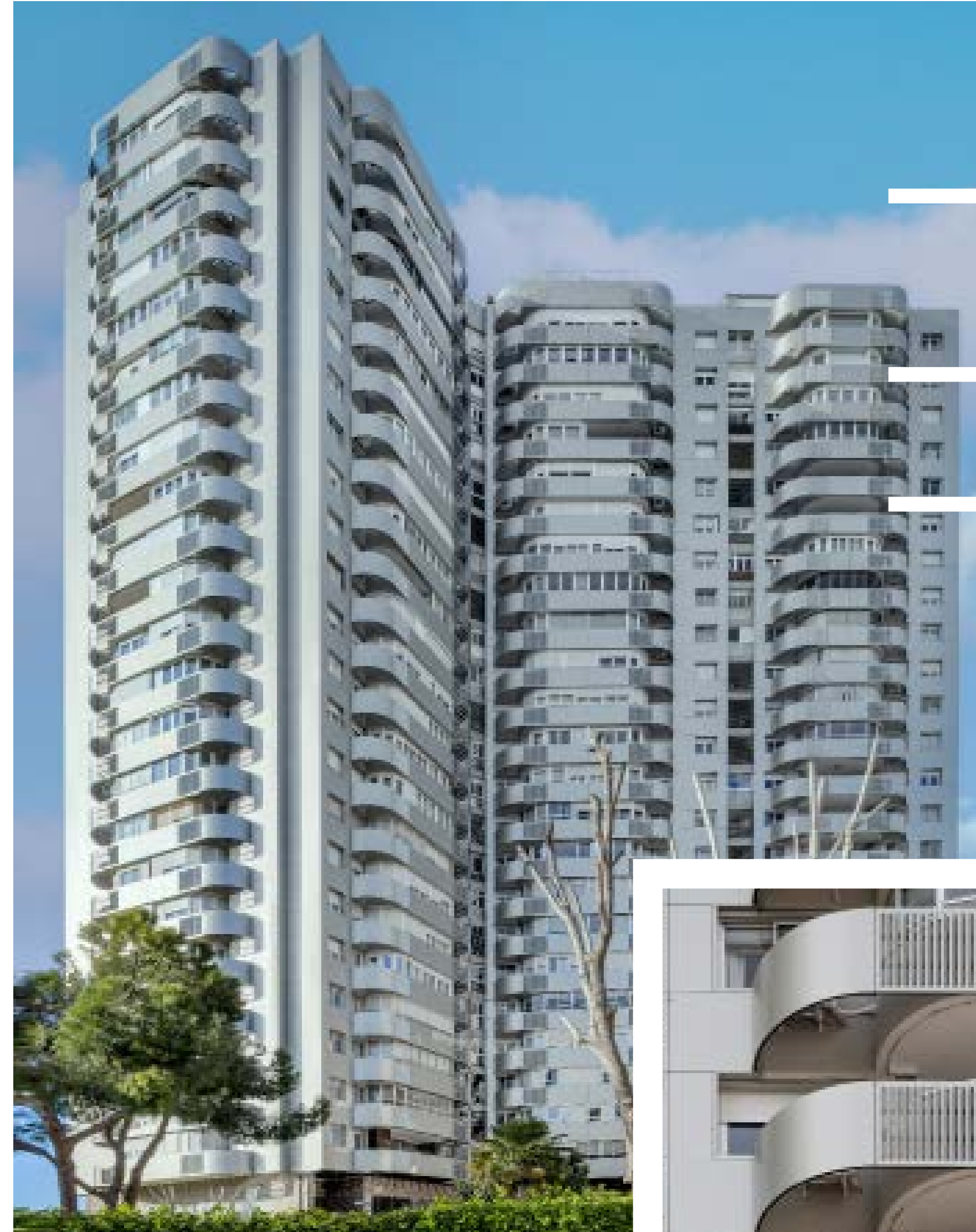
Edificio en calle del Condado de Treviño (Madrid)
